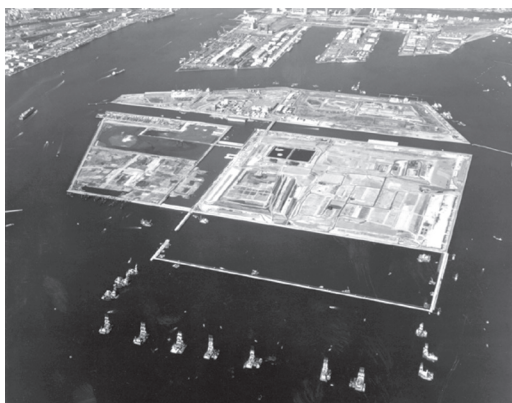
写真1 新海面処分場の建設状況（平成11年） [出典：東京都清掃事業百年史]
